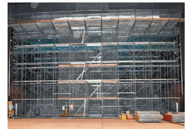
中ホール(工事の様子)
